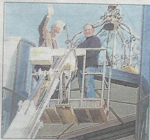
Une nacelle a permis d'inspecter la toiture.
